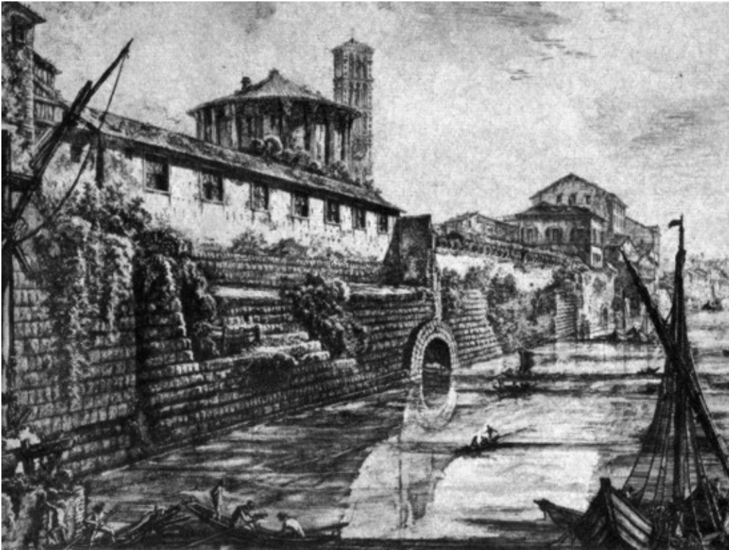
La Cloaca Máxima, alcantarilla principal de Roma, construida en el siglo VI a. de C. para desecar el pantano donde se edificaría posteriormente el Foro.
