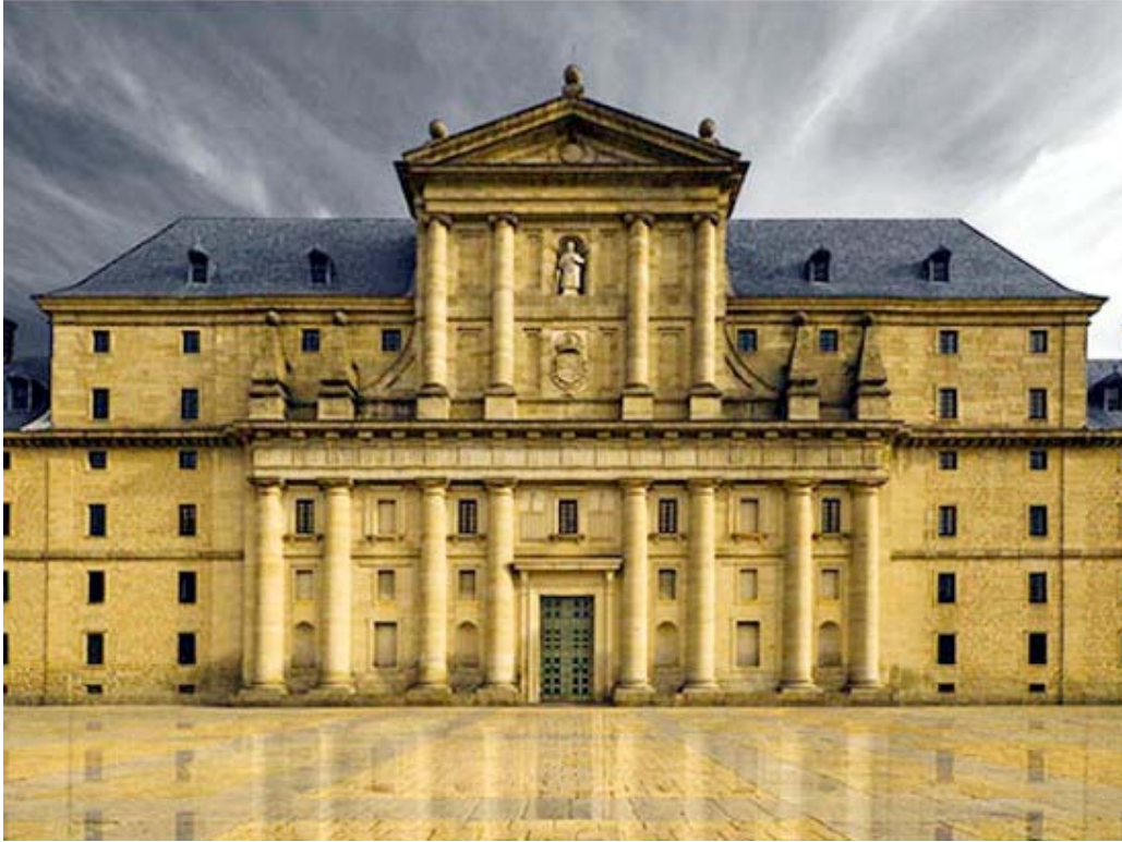
San Lorenzo de El Escorial (1563-84) por Juan Bautista de Toledo y Juan de Herrera: macizo y sombrío, es la culminación de la arquitectura española del Renacimiento.
